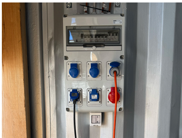
Slika 1.2.: Priklop elektrike v električno omarico
