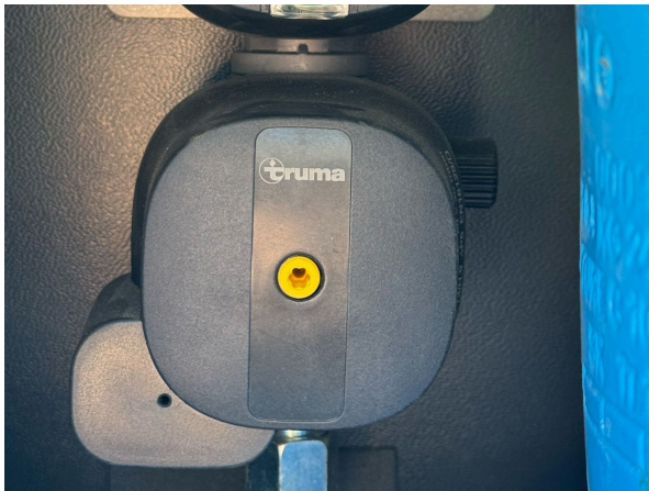
Slika 5.7.: Mono control (crash senzor) - pritisni rumeno tipko za sprostitvev dovoda plina
