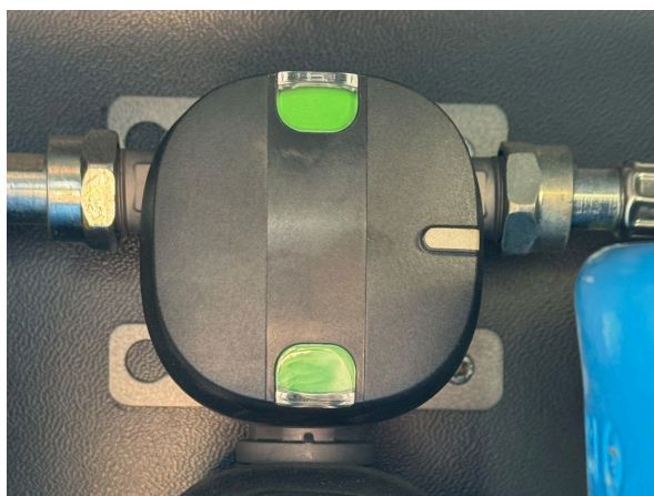
Slika 5.6.: Duo control ventil
