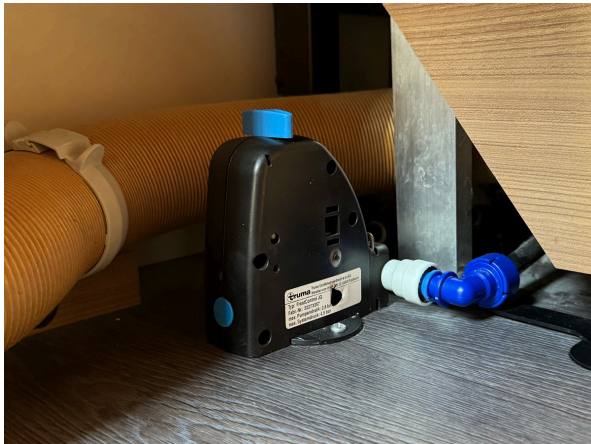
Slika 3.4.: Frost ventil
